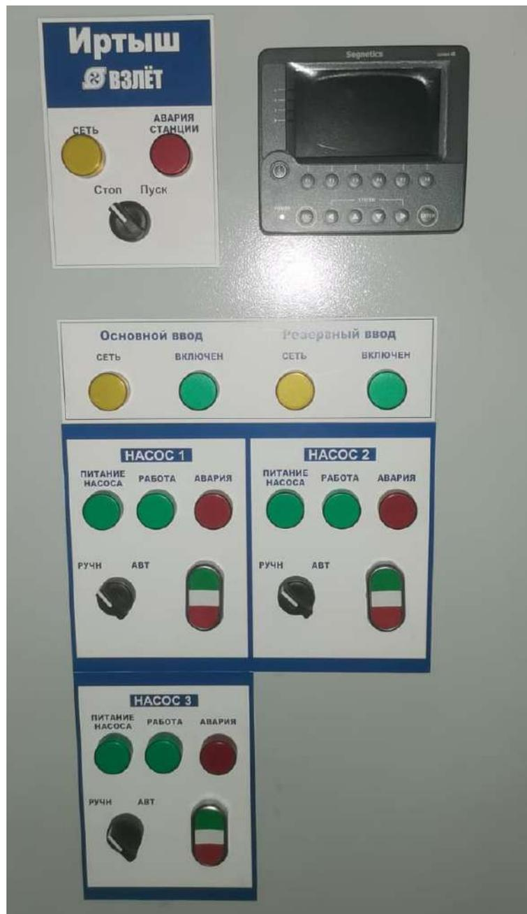
Рисунок 1 – Органы управления и индикации шкафа управления
