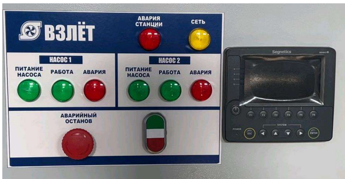
Рисунок 1 – Органы управления и индикации шкафа управления
